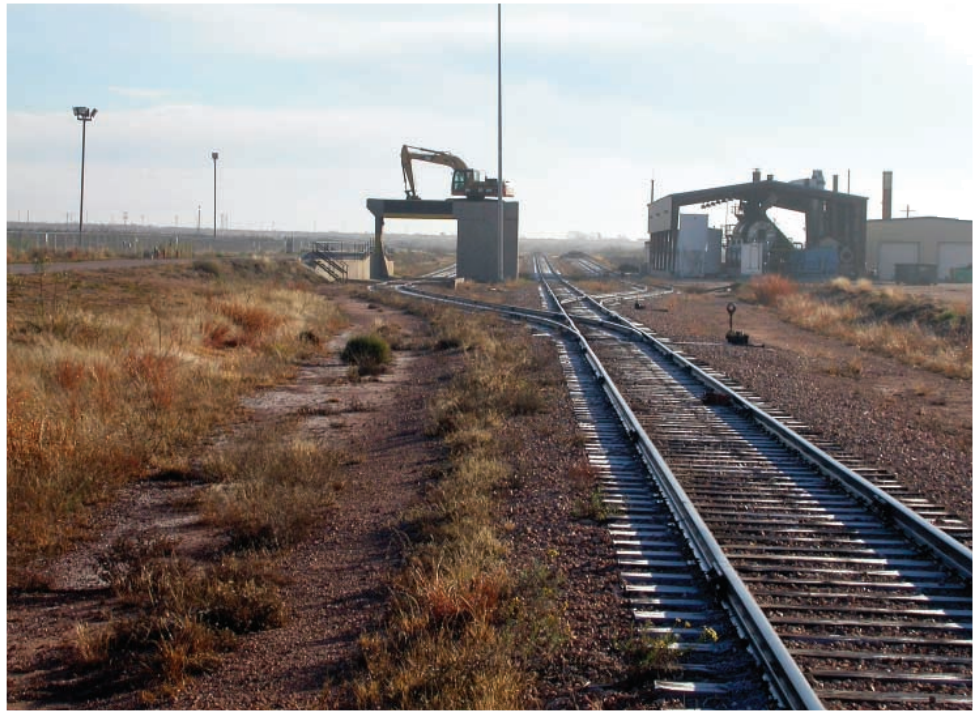
サイト内支線とゴンドラ車荷降ろし施設。
