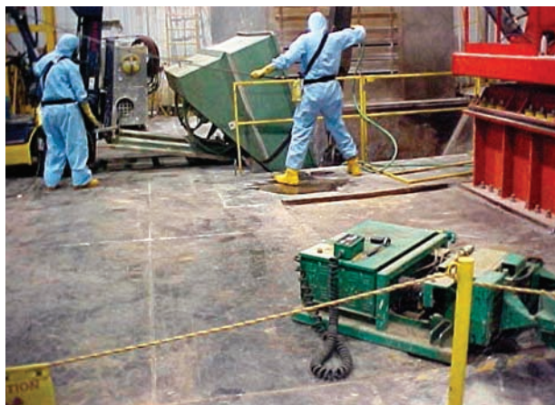
細断された廃棄物のミキシングパンへの移送。
