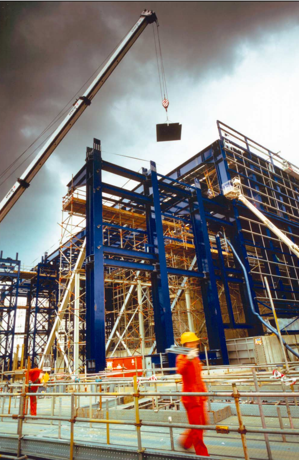
建設初期段階の綿状沈澱物回収施設。一部の初期貯蔵タンクから綿状沈澱物とスラッジを回収するために建設されているこのプラントは、近い将来に運転を開始する予定である。
