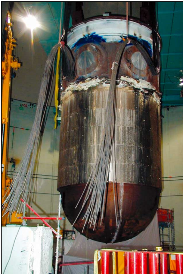
上：2002年8月に行われたメイン・ヤンキー原子力発電所の原子炉圧力容器取り外し作業。
