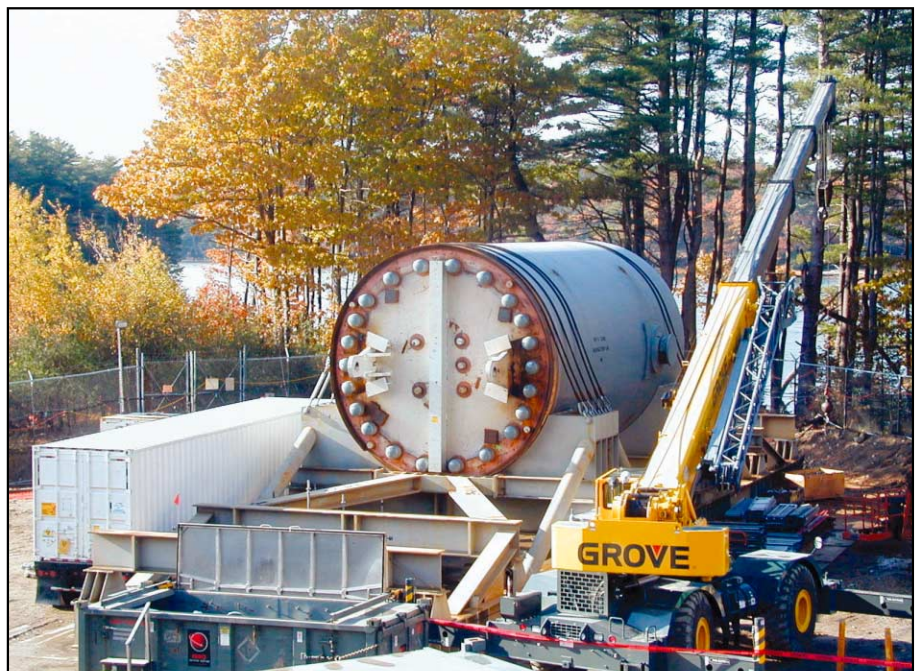
上：2002年8月に行われたメイン・ヤンキー原子力発電所の原子炉圧力容器取り外し作業。
