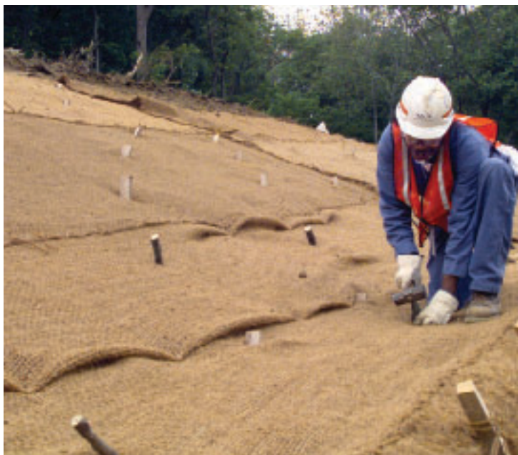
ファーナルド・サイトを流れる小川沿いの浸食防止と河岸安定処理のために生物工学的手法を用いる、フルーア・ファーナルド社の作業員であるハーブ・チャフィン氏。
