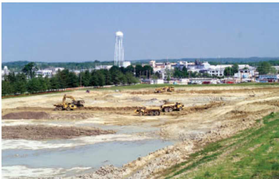
7セルからなるオンサイト処分施設の土層を構築するために、土取場の土壌、岩石、粘土が掘削された。土取場は、セル建設後に修復される。
